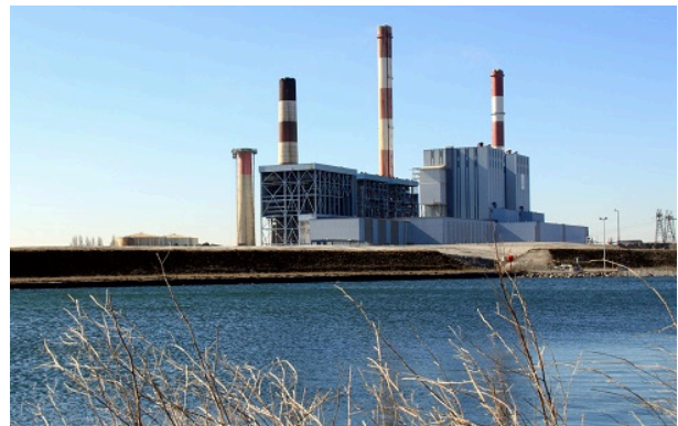
Illustration 4 : Photo d'une centrale thermique à flamme
