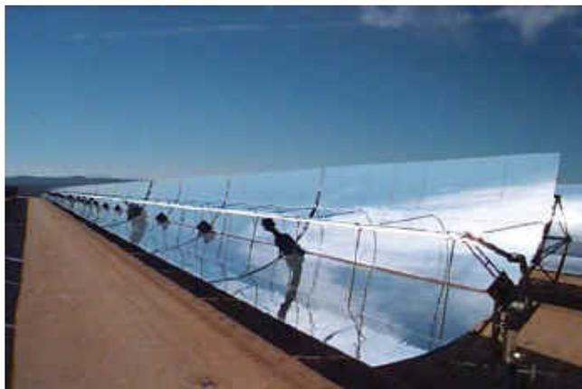
FIGURE 3.3: Le collecteur cylindro-parabolique
