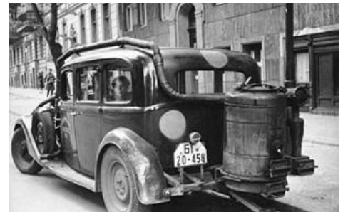
Illustration n°3- Voiture équipée d'un gazogène
