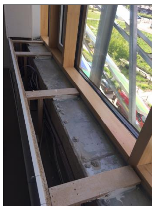
Isolation par l'intérieur et menuiseries
