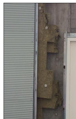
Isolation par l'extérieur: la fixation
