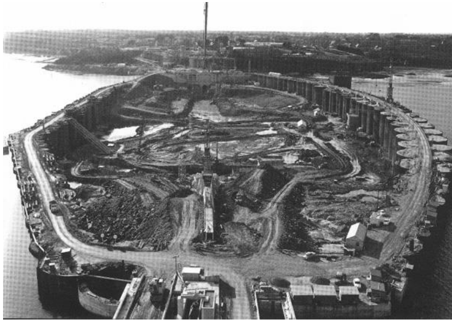
Photo du chantier de construction de l'usine de la Rance
