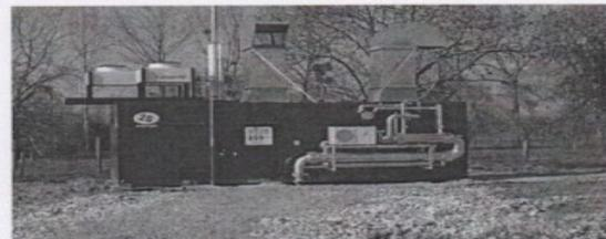
recherche de nouveaux revenus, l'entreprise agricole s'est naturellement intéressée à la méthanisation. Le principe de l'installation est simple : l'ensemble des déchets verts de l'exploitation (pommes, oignons, etc.) ainsi que les effluents d'élevage produisent du gaz qui alimente un moteur (220 kWelec). Ce moteur produit de l'électricité et de la chaleur. L'électricité est vendue à EDF et injectée dans le réseau. La
