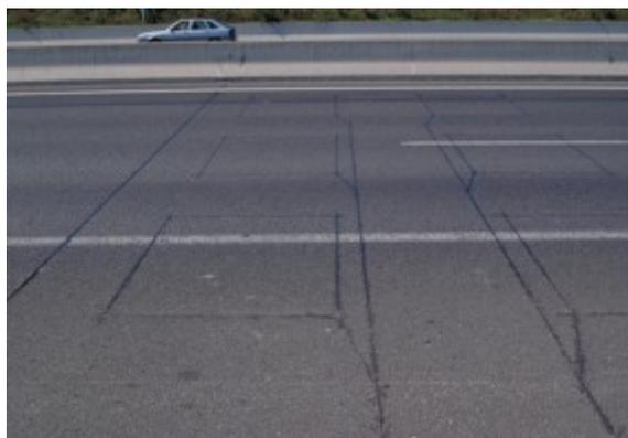
*Illustration 3: Capteur à boucle électromagnétique*
