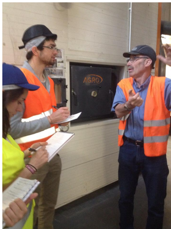
Explication du fonctionnement de la chaudière à Maromme lors de notre visite.
