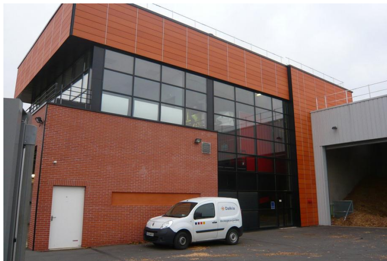
Chaufferie Grammont (Rouen)
