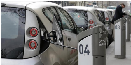
21-bornes de recharge autolib' (location courte durée de voitures 100% électriques)
