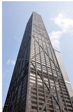
FIGURE 2.14 – Le John Hancock Center est un exemple de structure contreventée capable de résister à des vents violents ou à des tremblements de terre
