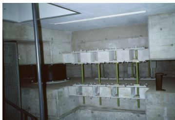
FIGURE 2.17 – Des amortisseurs hystériques couplés à un isolateur à déformation
