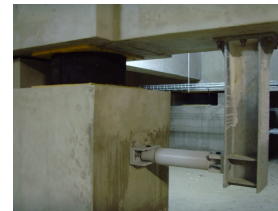
FIGURE 2.16 – Un isolateur à déformation
