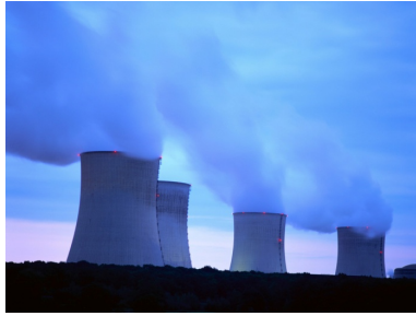
FIGURE 3 – Colonnes de refroidissement des centrales nucléaires
