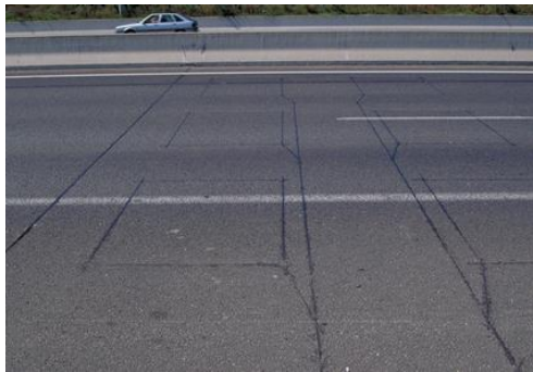
Fig 3 : Des boucles magnétiques dans une chaussée
