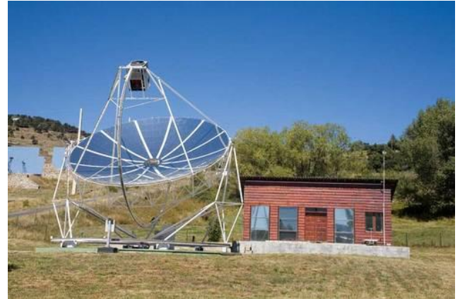
Figure 18 : Photo d'une parabole munie d'un moteur Stirling en son foyer
