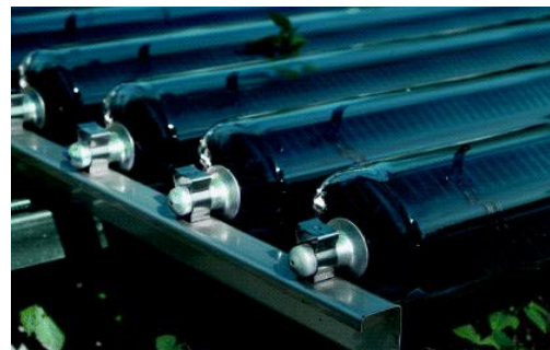
Figure 5 : Détail d'un capteur solaire sous vide, Fraunhofer Institut Freiburg
