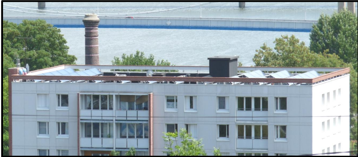
Figure 15 : Panneaux solaires de l'installation d'Elbeuf
