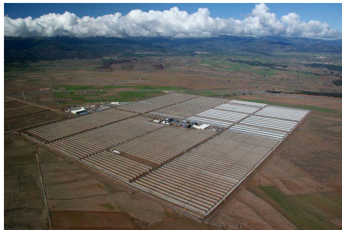
Illustration 11 : Centrale solaire Andasol 1 en Andalousie(Espagne)
