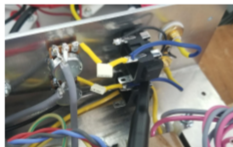
Ajout des condensateurs sur l'amplificateur
