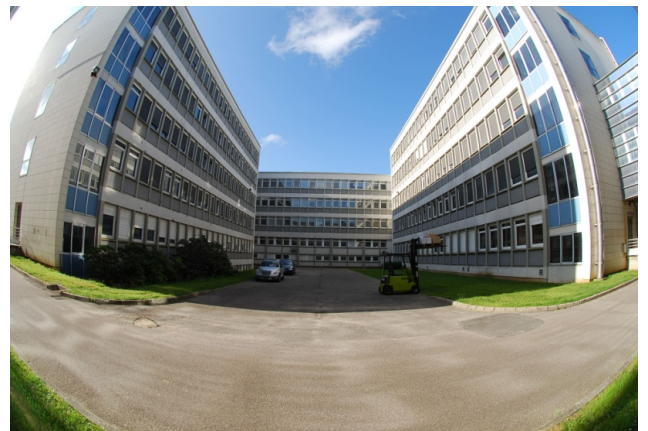
Figure 2 : photo d'un bâtiment de l'INSA prise avec objectif fish-eye
