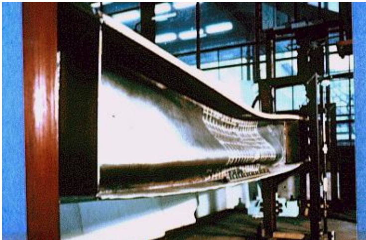
Flambement global de l'ame de la poutre
